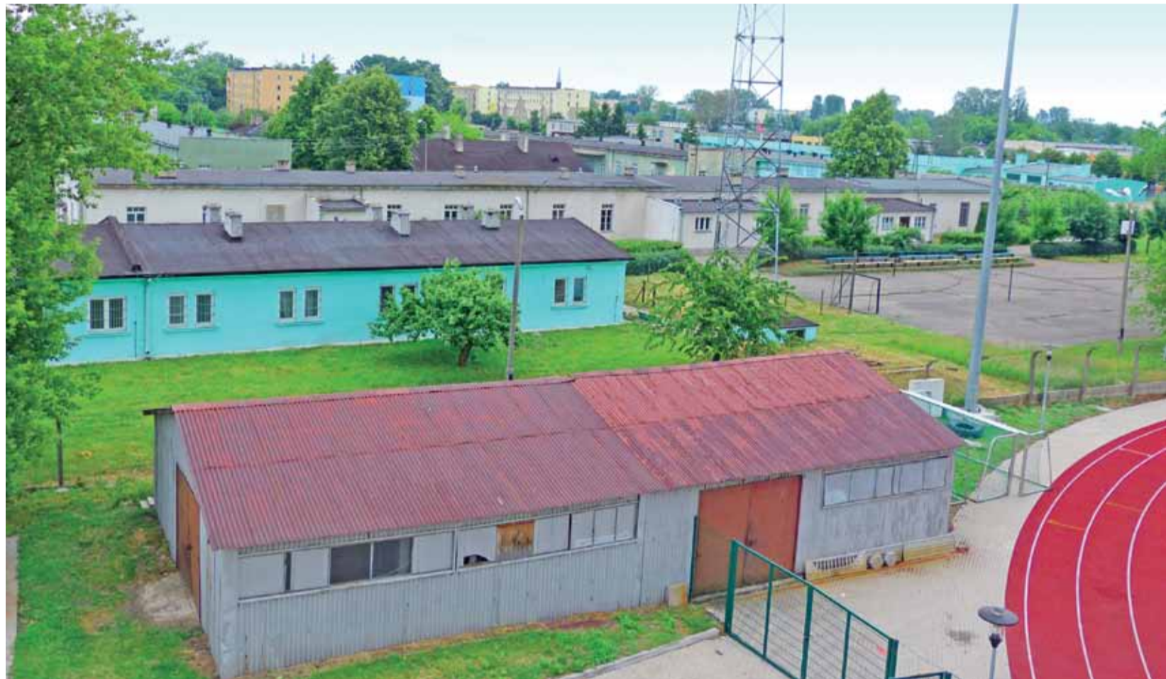
Z wysokości kilku pięter widać dopiero, że na terenie wojskowym jest wiele budynków, w większości jednokondygnacyjnych. Żeby zagospodarować ten teren na nowo, potrzebne będą więc nakłady na rozbiórkę. Wiata na pierwszym planie to jeszcze własność OSIR-u.
