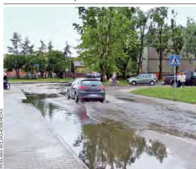
Duża i głęboka kałuża tworzy się po większych opadach deszczu na ul. Młodzieżowej w Łowiczu, na odcinku pomiędzy ul. Papięską a Ulańską. Co gorsze, w miejscu, przejścia dla pieszych jest ona najgłębsza.
