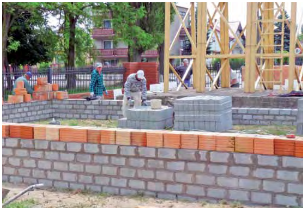
W tym roku mają powstać mury kaplicy oraz zostanie ona zadaszona.
