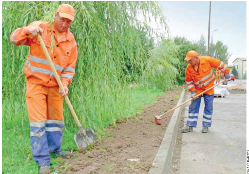
Pracownicy PRID w Łowiczu w czasie prac porządkowych po ustawieniu nowych krawężników wokół zatoczek parkingowych.
