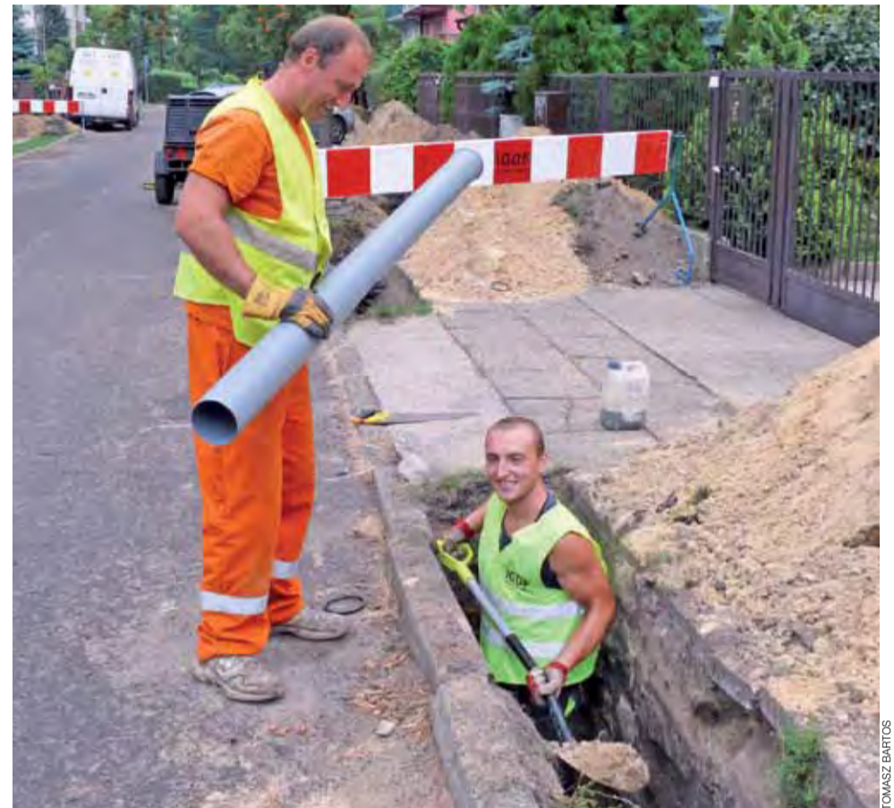
Pracownicy pabianickiej firmy w czasie układania sieci gazowniczej na ul. Słowackiego.
