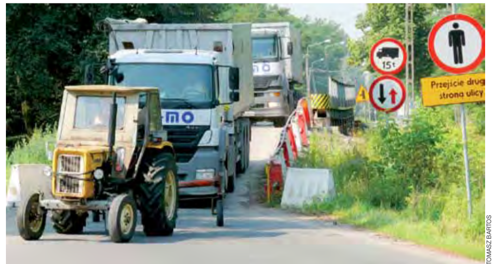
Nadbudowana stalowa konstrukcja nad mostem w Bełchowie zostanie na swoim miejscu do końca września, ciągle jest wykorzystywana w czasie przewozów kruszyw z bazy DSS w Bełchowie.
