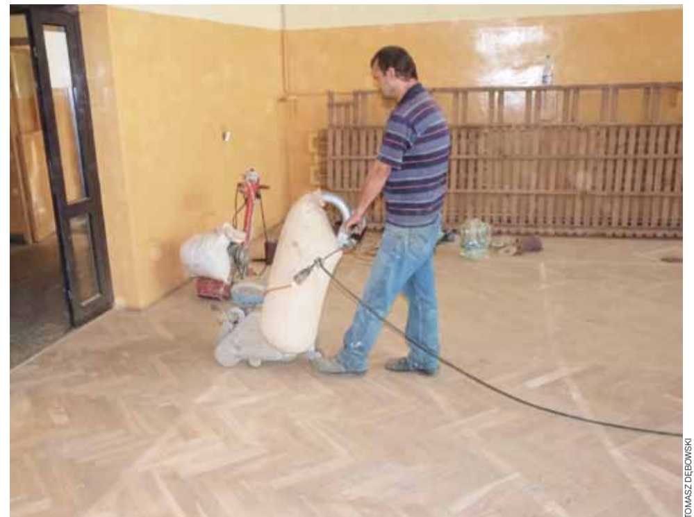
W szkole przy Grunwaldzkiej trwają wakacyjne remonty. Cyklinowana jest podłoga na sali gimnastycznej.
