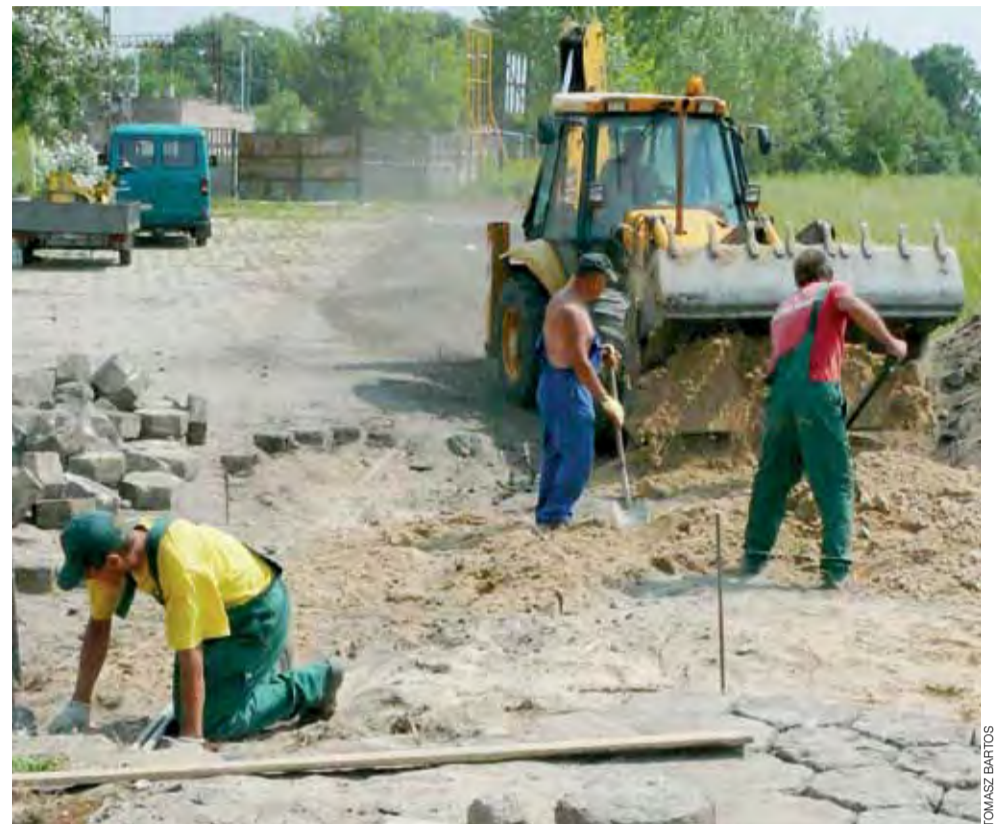
Pracownicy Zakładu Usług Komunalnych w Łowiczu układają na części dawnej rampy olejowej trylinkę. Niedługo staną na niej samochody.
