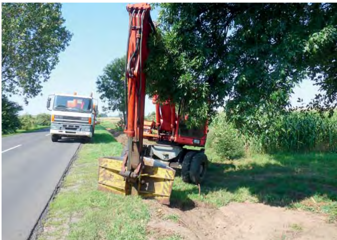
Około 3,7 km rowu od Chruslina w gminie Bielawy po okolicie Łowicza wyczystała firma Hoga z Gomulina na zlecenie Rejonu Dróg wojewódzkich w Łodzi. Renowacja rowów polegała na oczyszczeniu ich z mułu i zalegających tam gałęzi oraz na ich pogłębieniu. Ma to służyć lepszemu odprowadzaniu wody. Prace przebiegały na wybranych fragmentach po prawej stronie, jadąc z Łowicza w kierunku Bielaw. td
