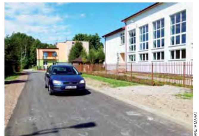
348 tys. zł kosztowała gminę Domaniewice budowa 2 ulic gminnych: Zagajnikowej i Szkolnej. Inwestycję wykonało Przedsiębiorstwo Robót Inżynieryjno-Drogowych z Łowicza. Prace zakończyły się w połowie lipca i od tamtego czasu mieszkańcy mogą już jeździć nowymi ulicami. am
