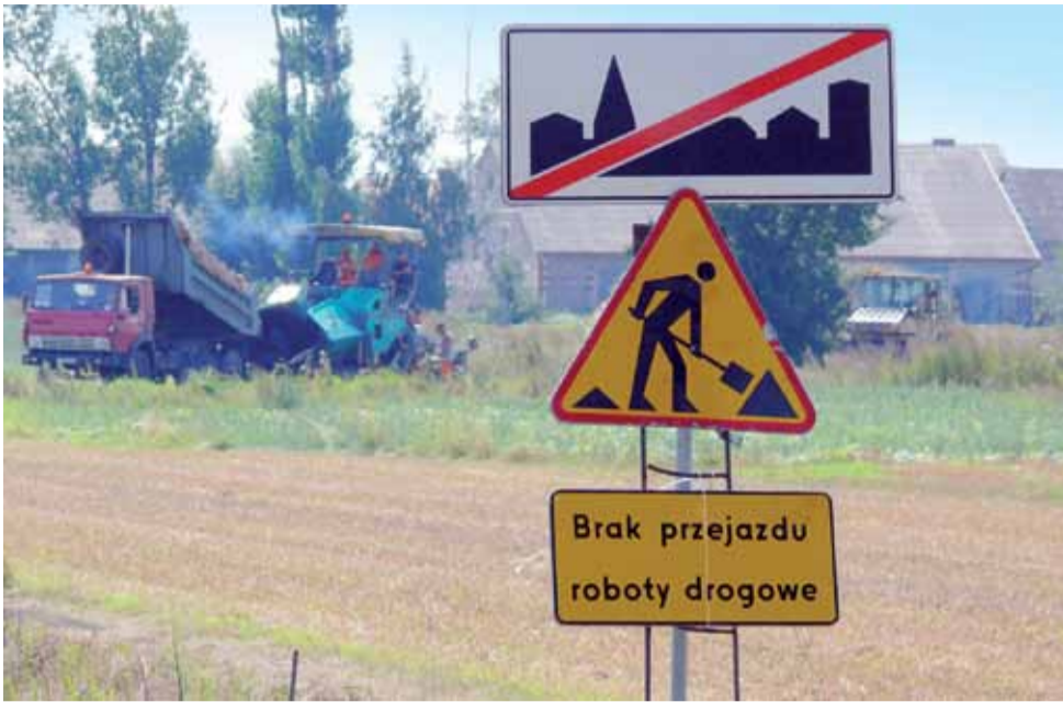
W Łaguszewie układana była w ubiegłym tygodniu nawierzchnia. Przejazd przez wieś w ciągu dnia był niemożliwy.
