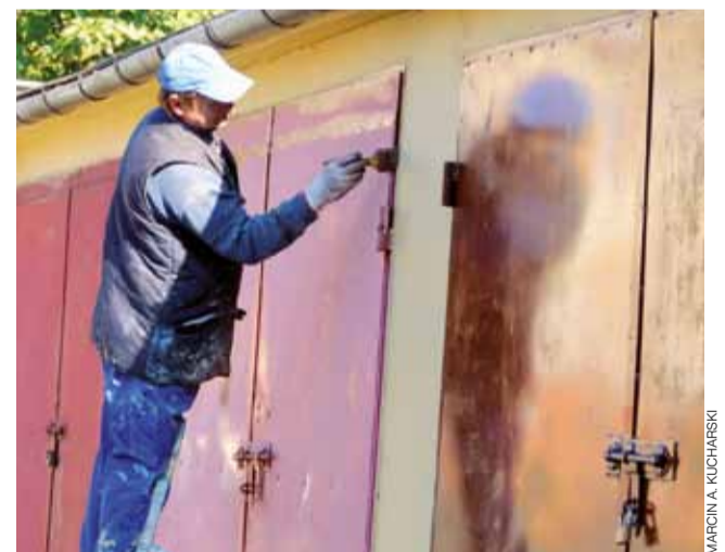
Malowanie garaży na Reymonta potrwa jeszcze przynajmniej tydzień.
