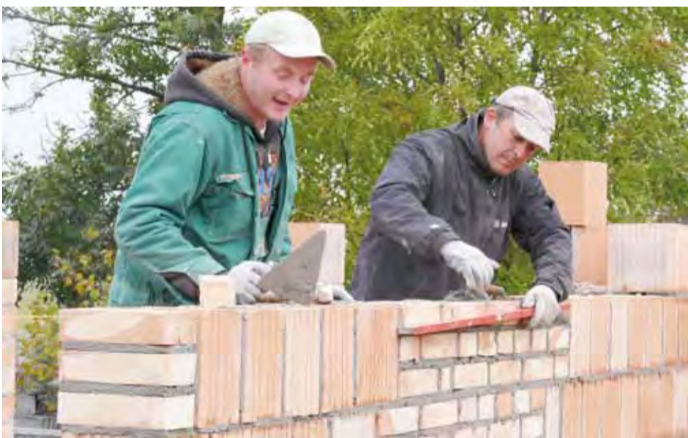
Pracownicy skierniewickiej firmy kończą w Karolewie murować ściany parteru przyszłej świetlicy.
