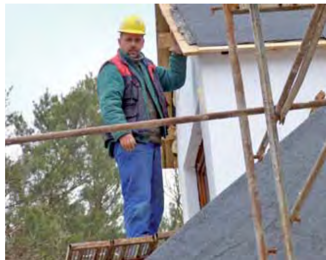
Pracownik Zakładu Remontowo-Budowlanego Józefa Melki z Kutna dociepla lukarny.
