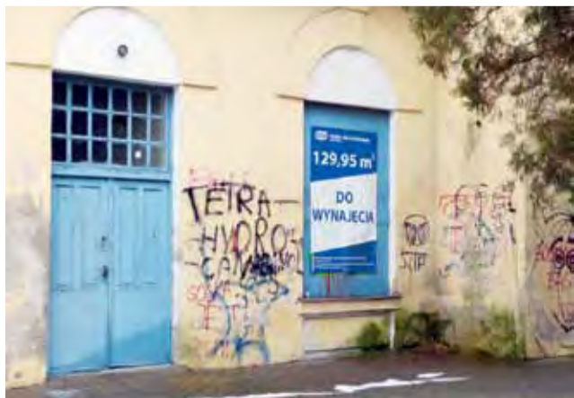
Budynek dworca Łowicz Przedmieście od strony peronów jest coraz bardziej zdewastowany.
