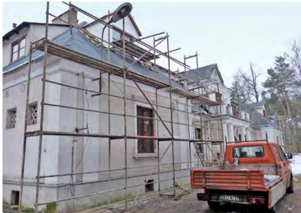
Budynek szpitala pokryje blacha cynkowo-tytanowa. Z zewnątrz ściany nie będą docieplane, czeka je tylko malowanie.
