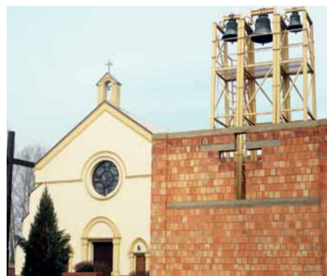
Kaplica powstaje bezpośrednio w sąsiedztwie kościoła w Łyszkowicach.
