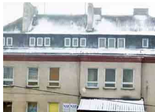
Dach na sannickim ośrodku zdrowia pokryty jest zawierającym substancje rakotwórcze eternitem.
