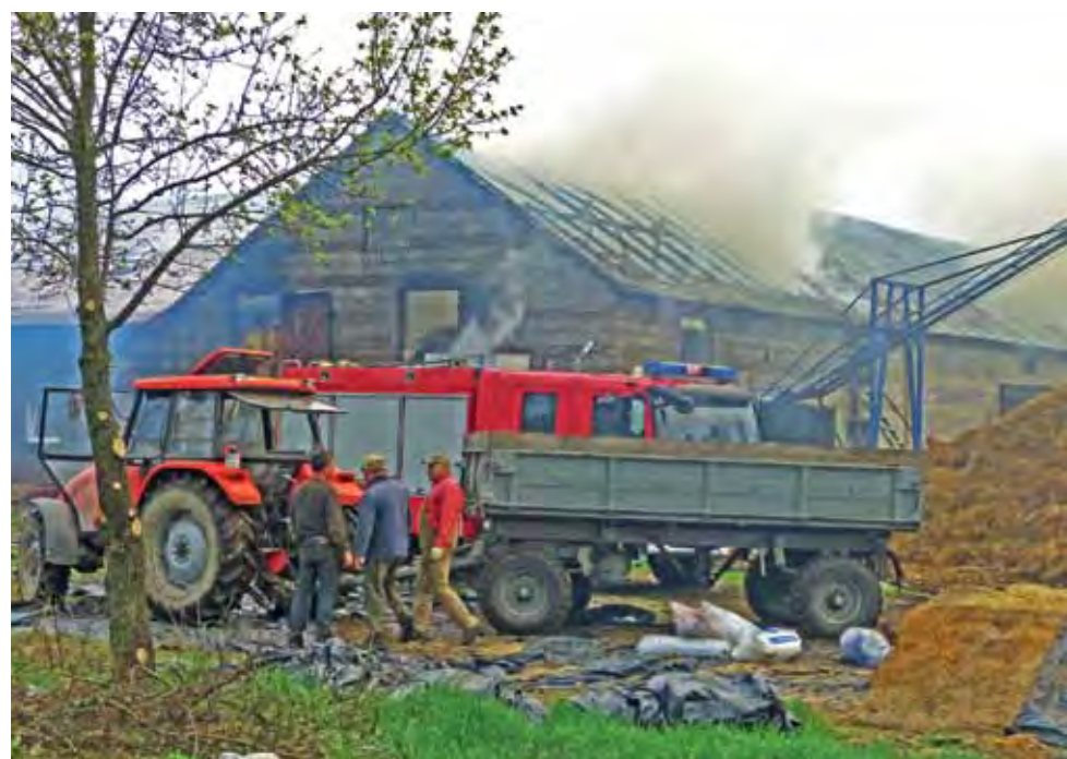
Stodoła pokryta eternitem była jednym z budynków, które uszkodził ogień. Tu jeszcze widać nadpaloną konstrukcję dachu, która po krótkim czasie runęła.
