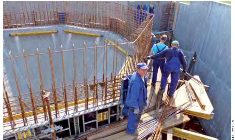
W oczyszczalni w Strugienicach nadal trwa budowa reaktora biologicznego. Zbrojeniem zajmuje się kilku pracowników firmy Markopol.
