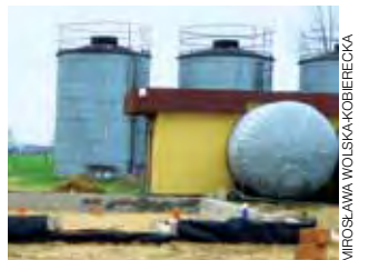
Budowa stacji w Kocierzewie.
