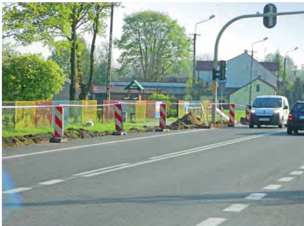
Trwają prace drogowe przy światłach na trasie krajowej nr 14 w Jamnie, budowany jest chodnik, głównie z myślą o uczniach szkoły.
