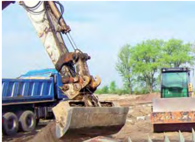
Prace ziemne na targowisku w Łyszkowicach są na ukończeniu. Teraz czas na układanie kostki i montaż wiat.
