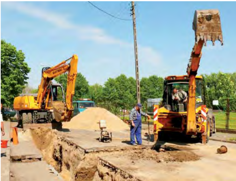
Prace na ul. Długiej w tym tygodniu prowadzone są już w bezpośrednim sąsiedztwie ul. Podgrodzie.
