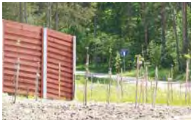
Przeście dla zwierząt wybudowane na wysokości Michałówka powstało w bardzo niefortunnej lokalizacji, tuż przy nim przebiega gminna droga, a nieco dalej tereny przeznaczone pod zabudowę.
