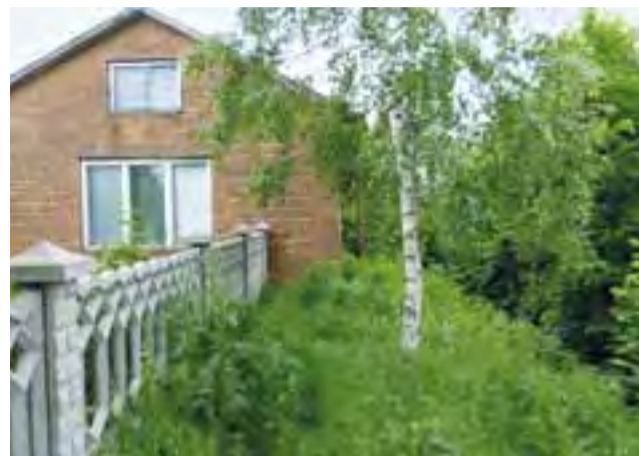
Budynek gospodarczy stoi na granicy. Rów, który zdaniem
