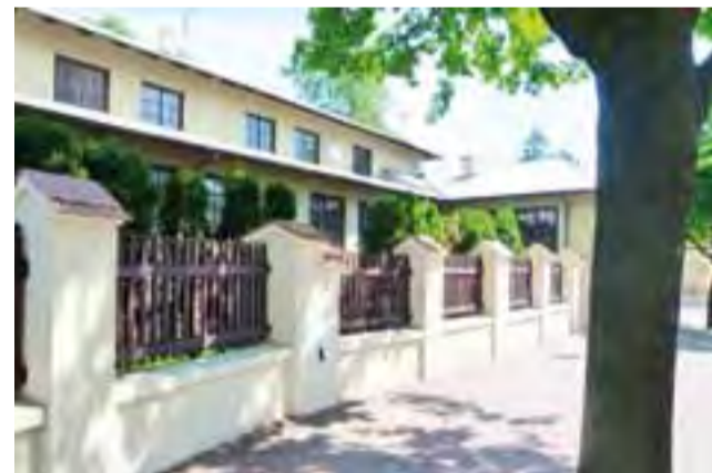
Dom parafialny w parafii katedralnej w Łowiczu. Jeden z ośmiu obiektów, które do końca roku mają zostać docieplone w ramach projektu termomodernizacji.
