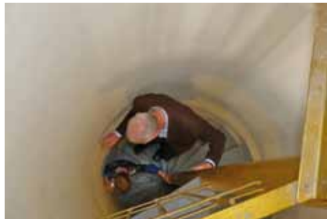
Bardzo wąska, kręta klatka schodowa w baszcie prowadzi do pomieszczeń na 3 poziomach.
