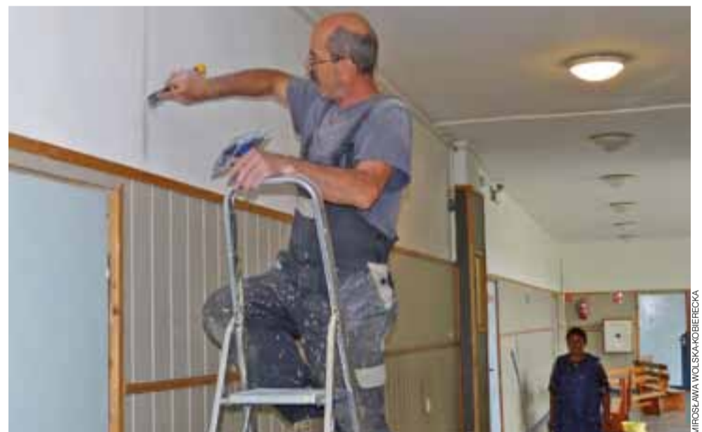
Prace na korytarzu szkoły prowadzą pracownicy obsługi. Na zdjęciu Andrzej Kucharek.
