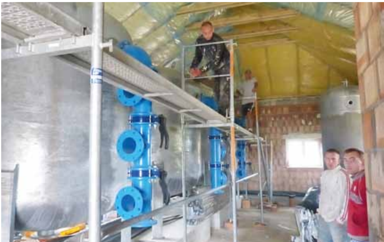
W budynku stacji w Kocierzewie Płd. trwają prace przy podbitce dachu. Jak widać, w środku są już zbiorniki do uzdatniania wody.
