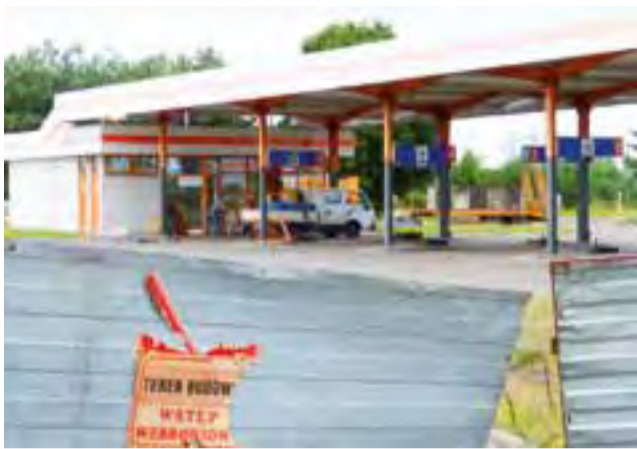
Prace rozbiórkowe na stacji trwają.
