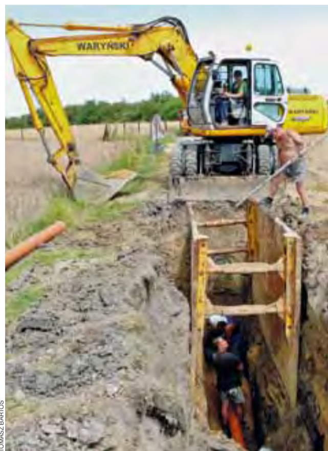
Wykopy pod kanalizację sanitarną w ulicy Sochaczewskiej mają ponad 4 metry głębokości i trzeba je kopać w glinie.
