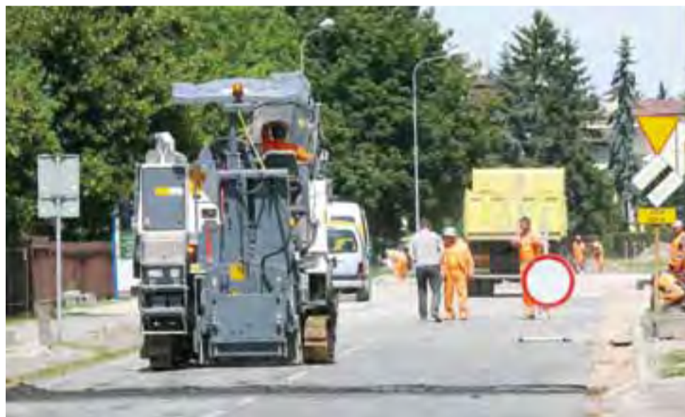
We wtorek 23 lipca kutnowska firma Trakt frezowała nawierzchnię ul. Bonifraterskiej, Ułańskiej i Długiej, w piątek 26 lipca rozpocznie układanie nowego asfaltu.
