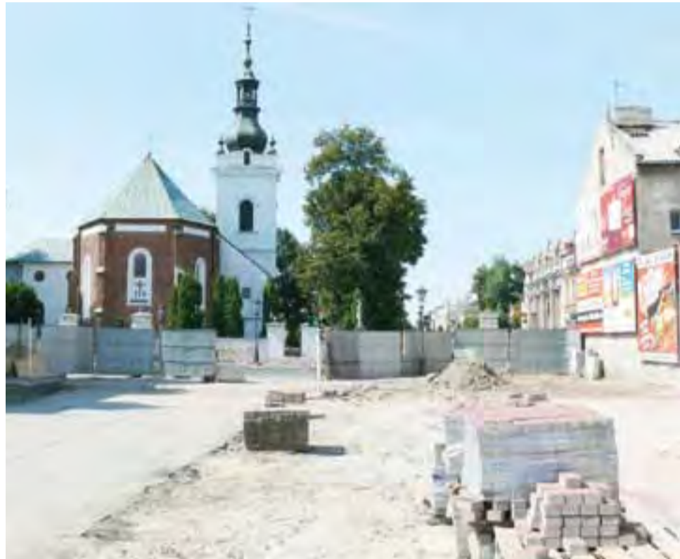
Prace już wykonane na ul. Kurkowej pokazują jak zmieni się ta ulica po ich zakończeniu.
