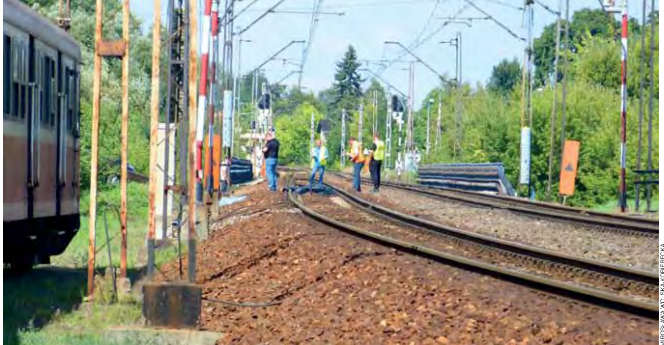
Miejsce wypadku widoczne od strony ul. 3 Maja w chwili, gdy prokuratura i służby kolejowe prowadziły swoje czynności.
