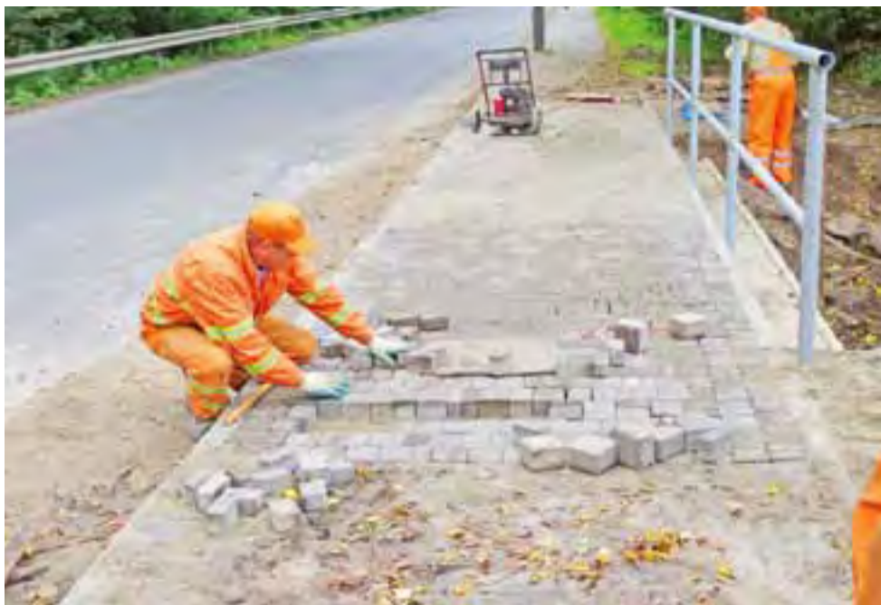
Po zakończonych pracach piesi będą mogli bezpiecznie przejść po tym mostku.
