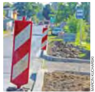
Roboty w Osmolinie były tak prowadzone, żeby jak najmniej utrudniać ruch na drodze.
