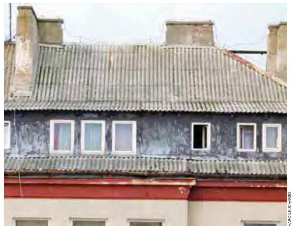
Dach na budynku ma zostać wymieniony do końca października tego roku.
