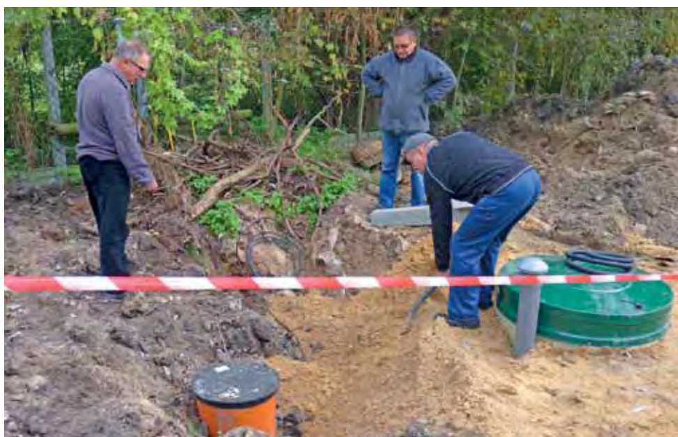
Rozpoczęte 30 września prace przy budowie oczyszczalni ścieków w Gągolinie Płd. w gminie Kocierzew Płd. 3 października były na ukończeniu. Elektrycy z firmy Cewokan z Łowicza, pod kierownictwem Adama Szymańskiego, montowali podłącze elektryczne. Gdy zrobiliśmy to zdjęcie, musiała być jeszcze poprawiona komora na pompę, ale do poniedziałku 7 października budowa się zakończyła. mst
