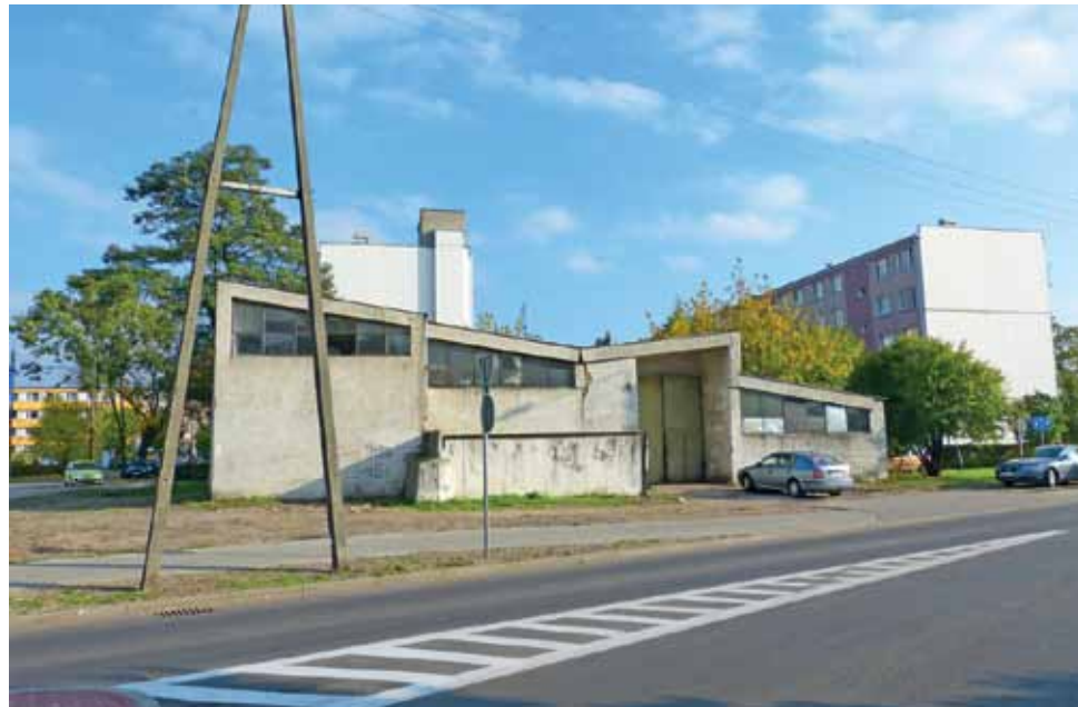
Blok powstanie w miejscu tej kotłowni na os. Dąbrowskiego, która za 2-3 tygodnie zostanie wyburzona.
