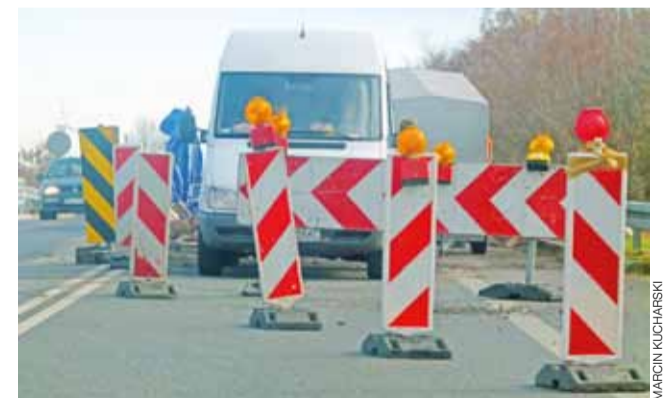
Ruch na moście w Maurzycach oraz wiadukcie w Łowiczu ciągle odbywa się wahadłowo.
