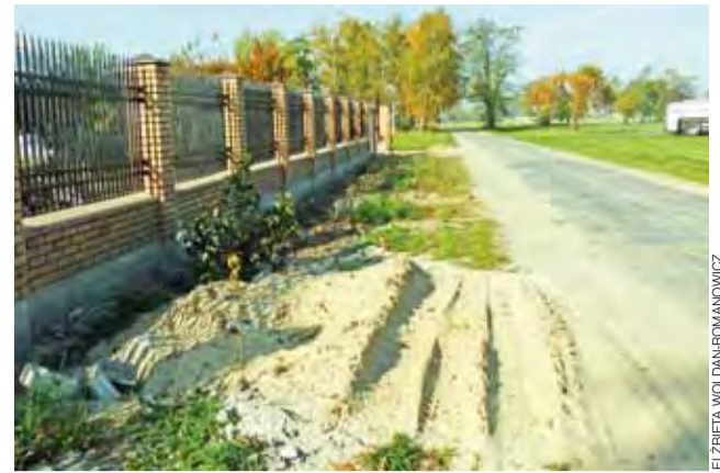
Gdzie będzie przystanek? Tu stała murowana wiata, ale podczas budowy prowadzonej na terenie po byłej szkole została zlikwidowana. Gmina szuka nowej lokalizacji.
