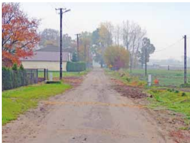
Asfaltowa czy gruntowa? Wójt mówi, że trzeba koniecznie zrobić coś z tą drogą w przyszłym roku, ale na nową nawierzchnię trzeba będzie poczekać nieco dłużej.
