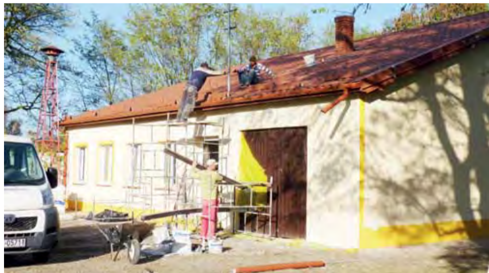
Dom Ludowy w Wygodzie został już odremontowany. Zdjęcie wykonano podczas ostatnich prac.
