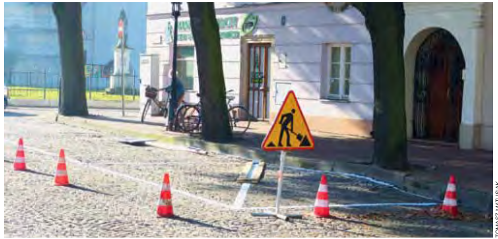
Nowa lokalizacja miejsc parkingowych dla niepełnosprawnych przy starym Rynku. Zdaniem burmistrza, ale też wielu mieszkańców, zdecydowanie lepsza niż na Zduńskiej.
