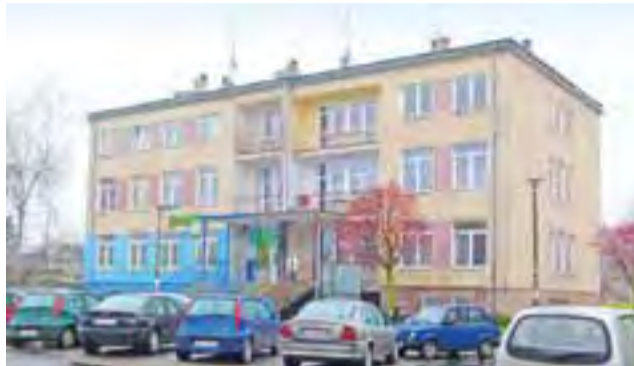
W centrum Bielawy. To w tym budynku, w lokalach wynajmowanych od gminy znajduje się przychodnia i apteka.
