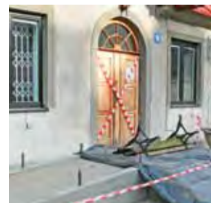
Wejście do budynku „B”
