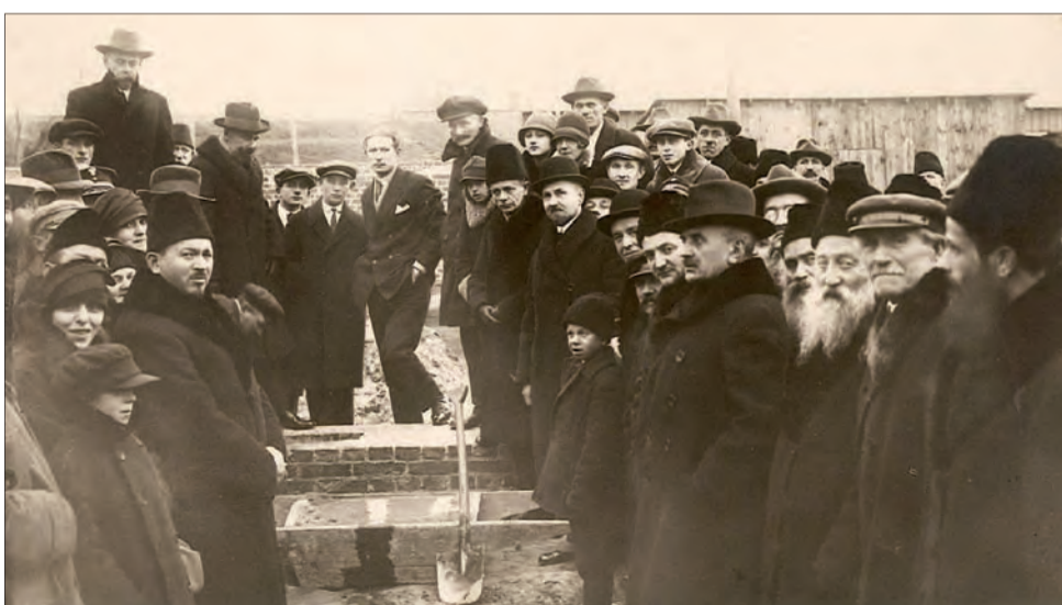
Położenie kamienia węgielnego pod budowę elektrowni w Łowiczu 4 XII 1927r., po prawej burmistrz dra K. Bacia, fot. ze zbiorów Archiwum Państwowego w Łowiczu
