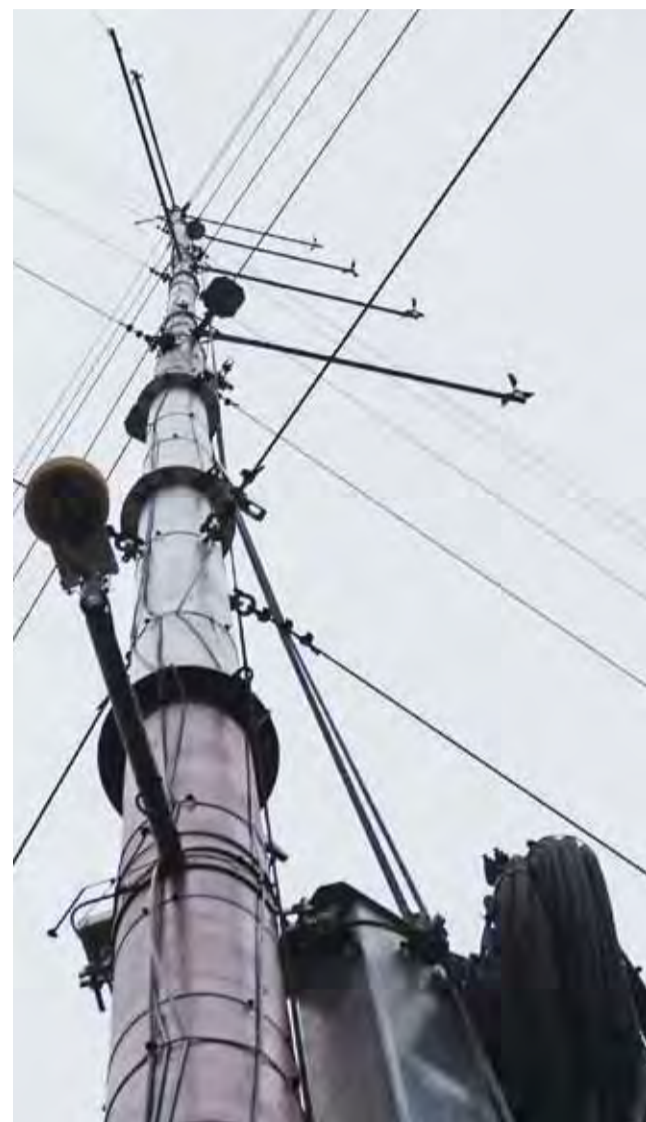
Maszt pomiarowy w Łągowie – pierwsza duża konstrukcja wzniesiona przez Bonwind w gminie Łyszkowice. Kiedy możemy spodziewać się wiatraków?
