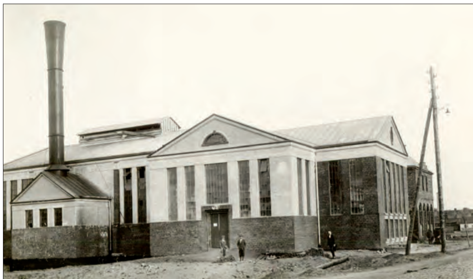
Elektrownia okręgowa w Łowiczu przy ul. Mostowej ok. 1930 r., zdjęcie ze zbiorów Archiwum Państwowego w Łowiczu
