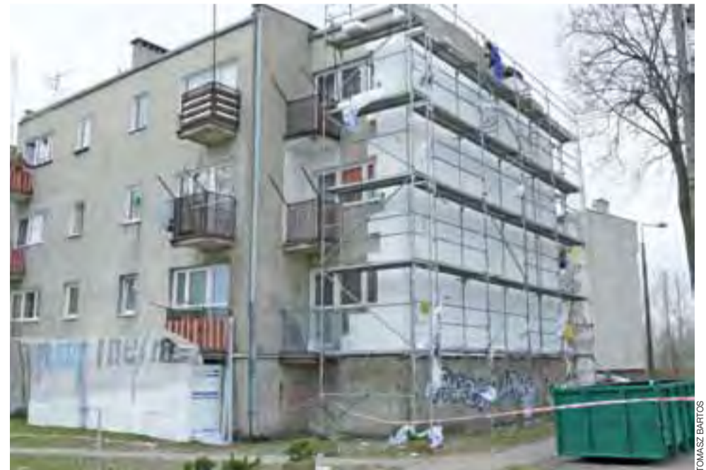
Termin zakończenia prac na bloku 43H przy ul. Armii Krajowej mija z końcem września, ale firma powinna dużo szybciej uporać się z tym zleceniem.
