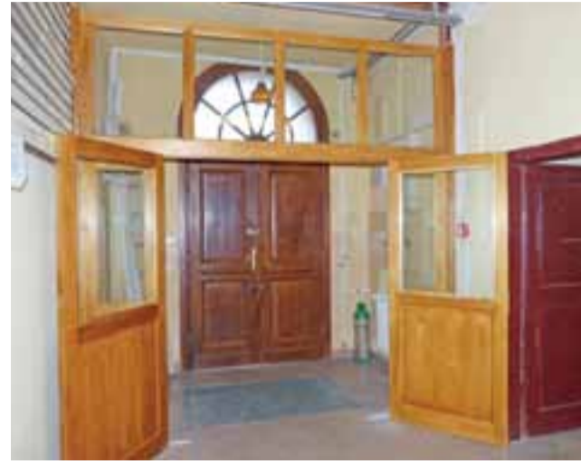
Remont przewidywał wymianę drzwi wiatrołapu przy głównym wejściu.
