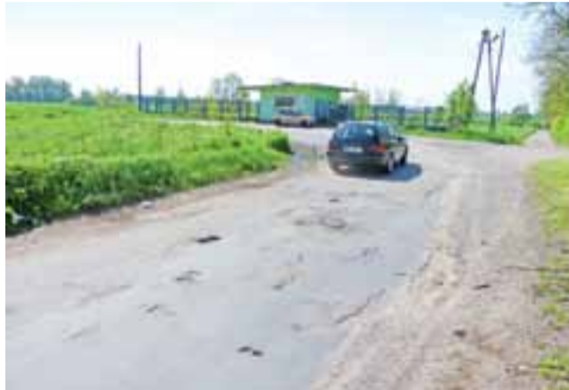
W ramach inwestycji wykonana ma zostać m.in. nowa nakładka asfaltowa na 2-kilometrowym odcinku w Jackowicach w gminie Zduny.
