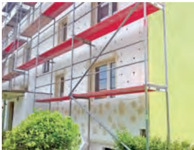
Roboty przy docieplaniu bloku nr 20 są zaawansowane.
