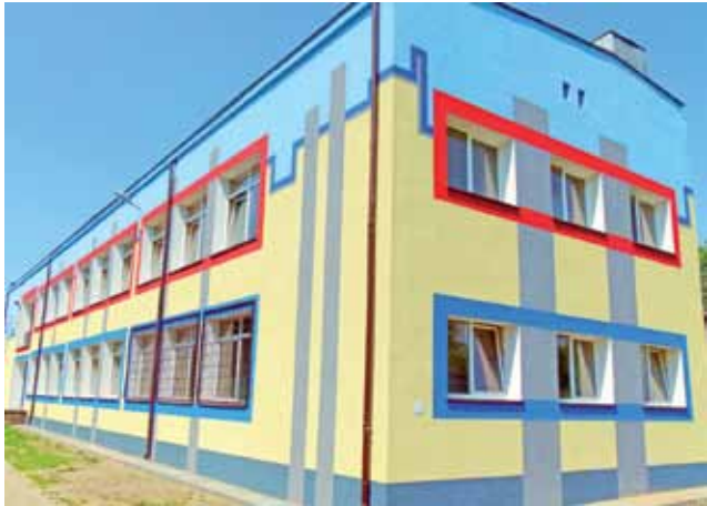
Budynek Szkoły Podstawowej w Osmolinie już docieplony.
