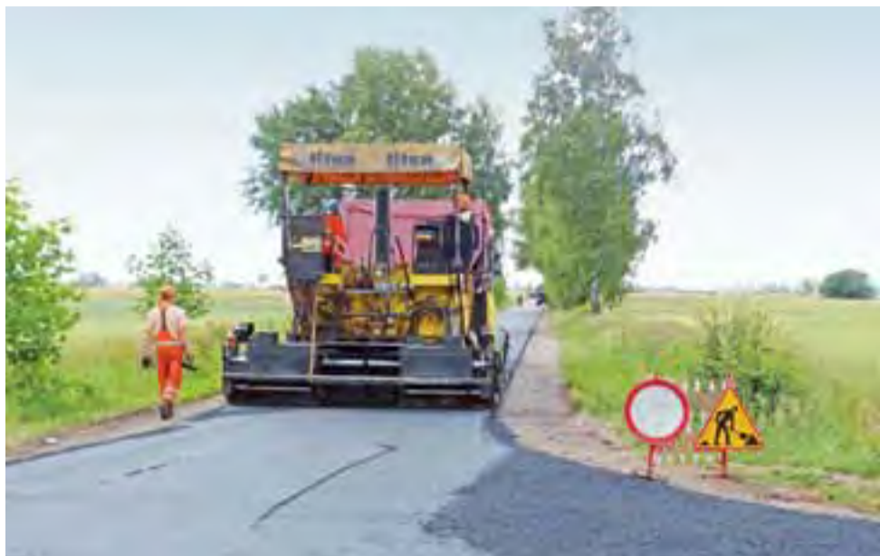
Prace PRID-u na skrzyżowaniu remontowanej drogi z wojewódzką 584.
