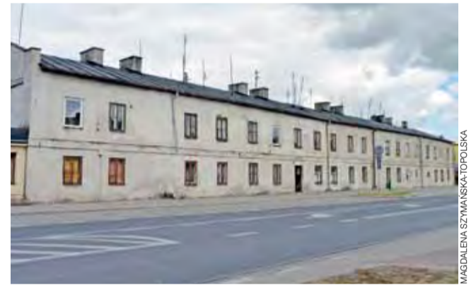
Ten budynek przy ul. Warszawskiej przeznaczony jest do rozbiórki.
