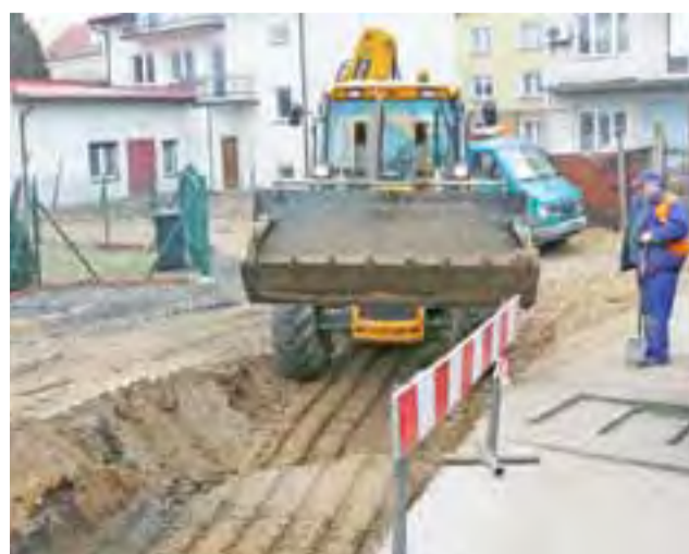
Po wykonaniu w ulicach Wegnera kanalizacji sanitarnej i deszczowej przyszedł czas na 100 m wodociągu oraz hydrant p.o.p.
