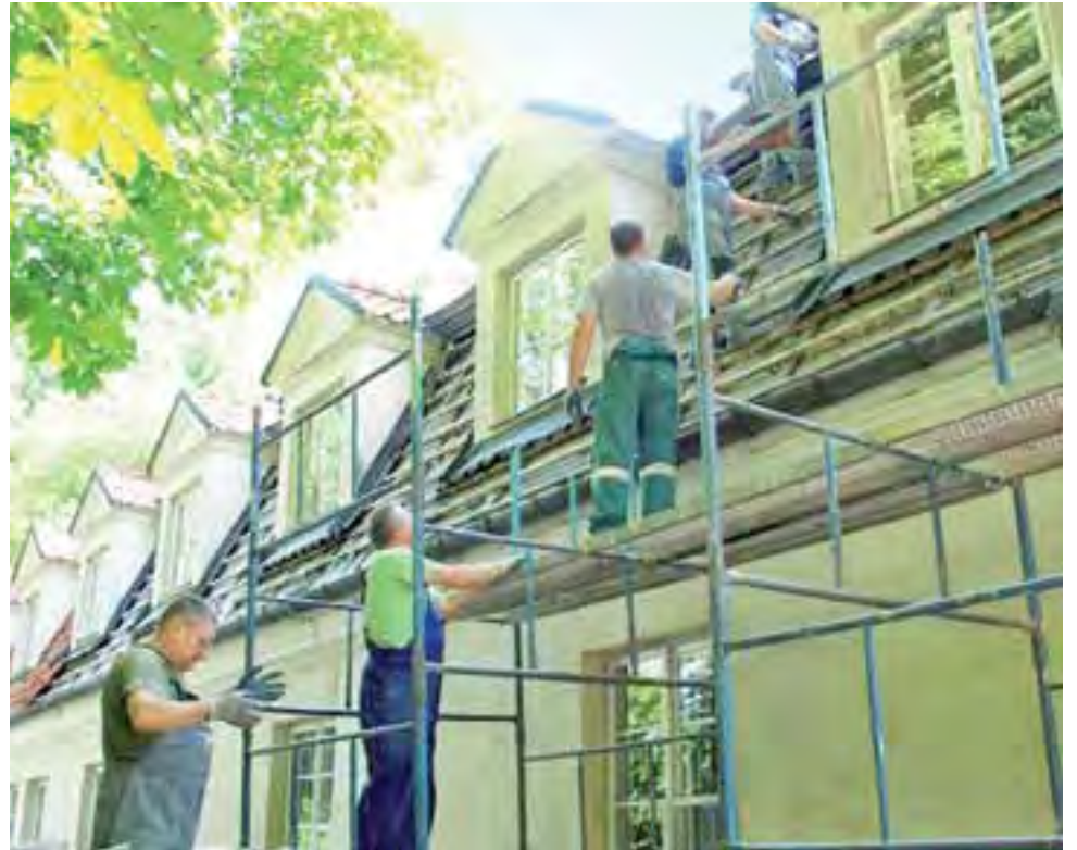
Pracownicy firmy z Nieborótu zdejmują stare dachówki z dachu pawilonu myśliwskiego przy pałacu w Nieborowie.
