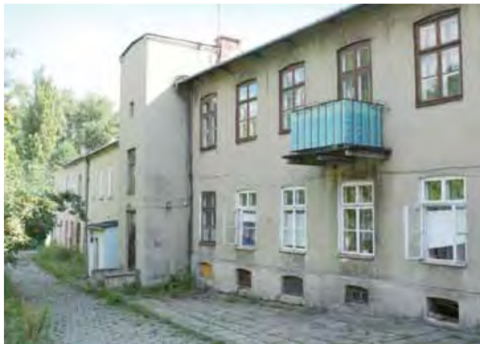
Oficina w podwórzu przy ul. Podrzecznej nr 12. Firma „Budowa” w ciągu 2 lat ma wybudować nowe budynki, w których znajdzie się ok. 30 mieszkań. Stare najprawdopodobniej w całości zostaną wyburzone.
