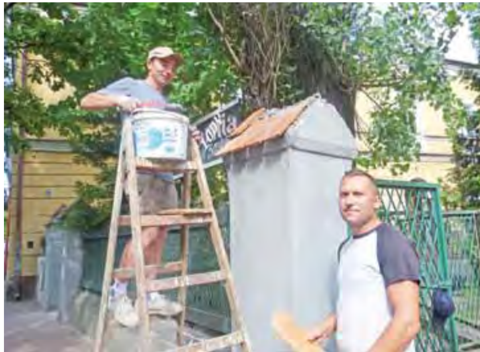
Ogrodzenie parku jest już remontowane. Wymienione będą jego drewniane elementy, a słupki przykrywane są dachówką. Na zdjęciu Sławomir Tomczak i Mariusz Zagawa.
