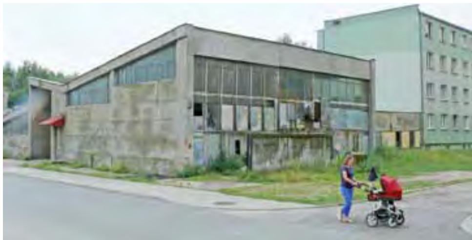
Kotłownie na os. Bratkowice dziś straszą mieszkańców swym wyglądem, jeśli znajdzie się inwestor, to może już niebawem w ich miejscu powstaną kolejne bloki mieszkalne.
