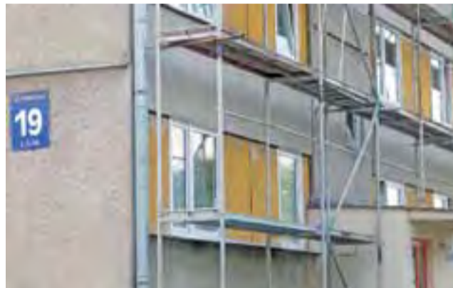
Przy budynku nr 19 na Bratkowicach ustawione zostały rusztowania, z których będzie prowadzone docieplanie.
