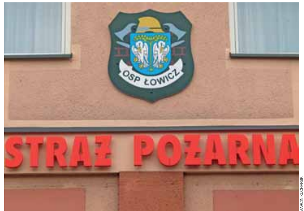
Na budynku Ochotniczej Straży Pożarnej przy ul. Św. Floriana w Łowiczu zawisła tablica zrobiona na wzór naszywki noszonej na mundurach strażaków z OSP Łowicz. Została zainstalowana nad napisem od frontu budynku strażnicy – nad bramami garażowymi. Kilka tygodni wcześniej gruntowny remont przeszły balkony na budynku. mak
