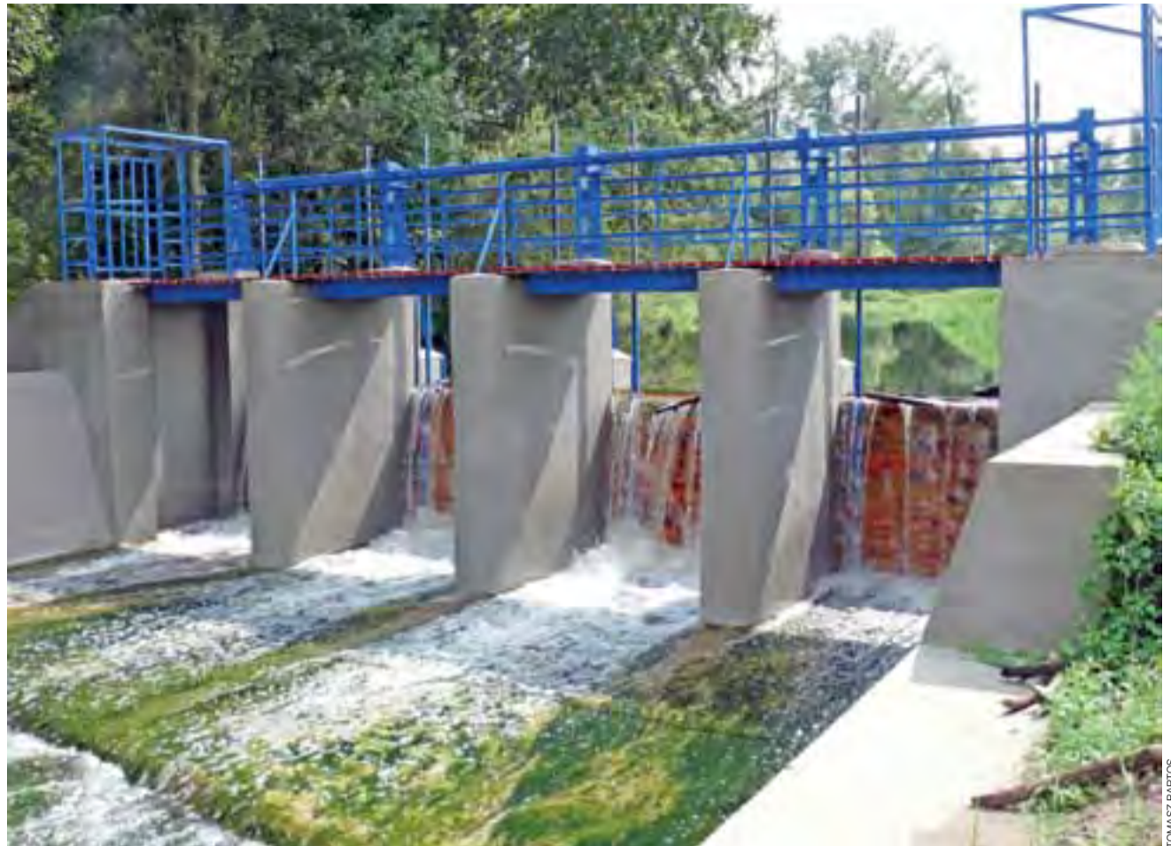
Jaz po remoncie w niczym nie przypomina stanu sprzed kilku miesięcy, gdy prezentował niemal całkowitą ruinę. Teraz woda w Skierniewce jest bez problemu piętrzona na ok. 2 m.
