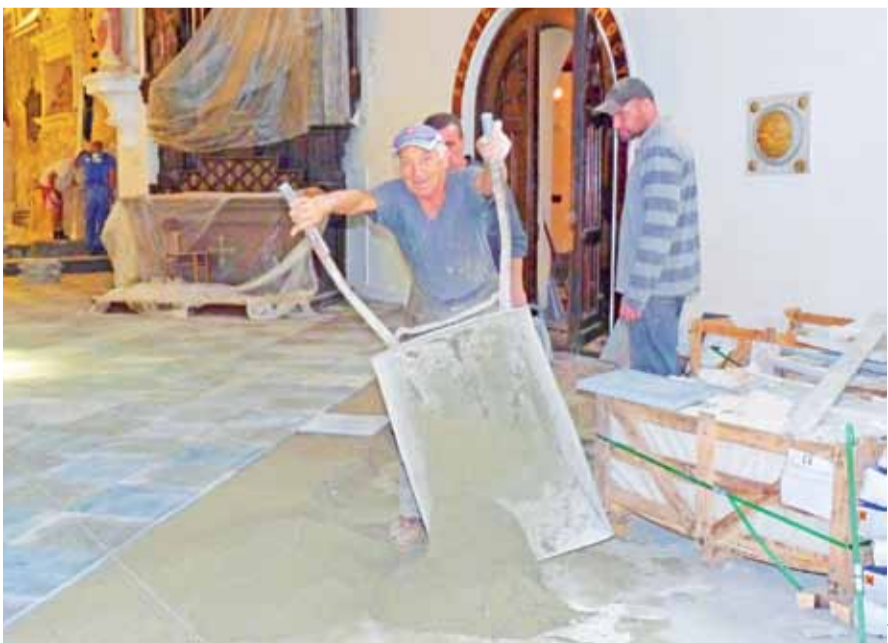
Prace przy zakładaniu nowej posadzki. Na pierwszym planie Józef Florczak.
