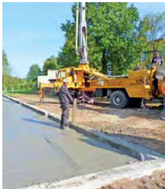
Wylewka pod salę. Takie prace toczyły się w środę 24 września.
