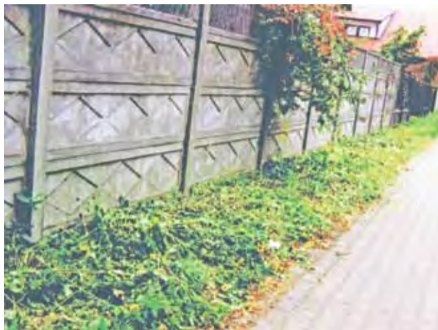
Wycięte przy chodniku rośliny odsłoniły betonowe ogrodzenie nieruchomości przy ul. Gen. Kutrzeby, obok zdjęcie takich samych dzierzaw, rosnących w ogródku.
