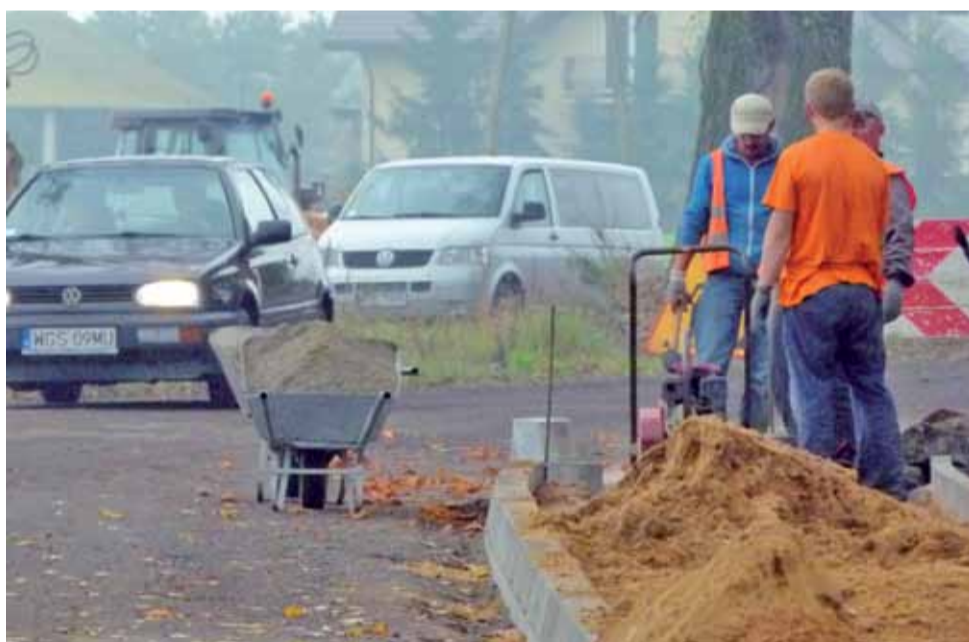
Przedsiębiorstwo Robót Inżynieryjno-Drogowych buduje chodnik na długości ok. 880 metrów od tzw. Czerwonej Góry w Łowiczu do granicy miasta z gminą Łowicz.
