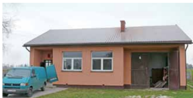
Strażnica OSP w Piaskach prezentuje się obecnie dużo lepiej z nowym dachem, teraz strażacy mogą myśleć o dalszych pracach remontowych.
