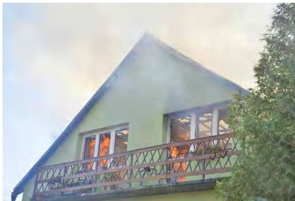
Wybuch gazu spowodował pożar, który zniszczył cały dach i wyposażenie poddasza użytkowego.
