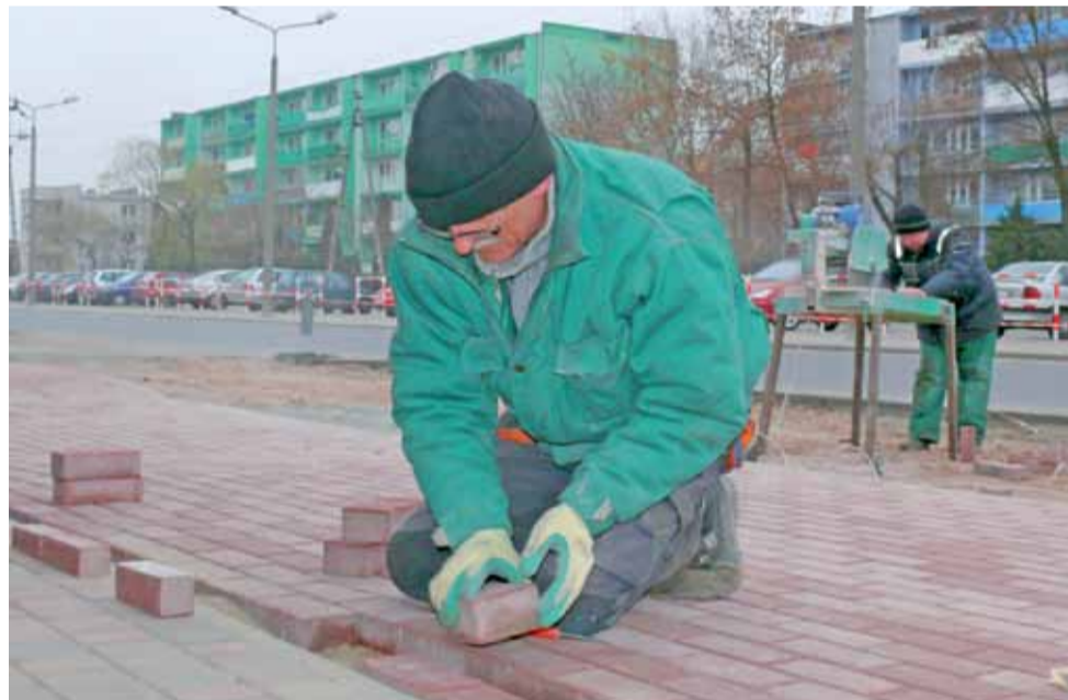
Przy ul. Tuszewskiej pracownicy ZUK układają kostkę brukową, w pierwszej kolejności powstaje chodnik, później kostka będzie położona na parkingu.
