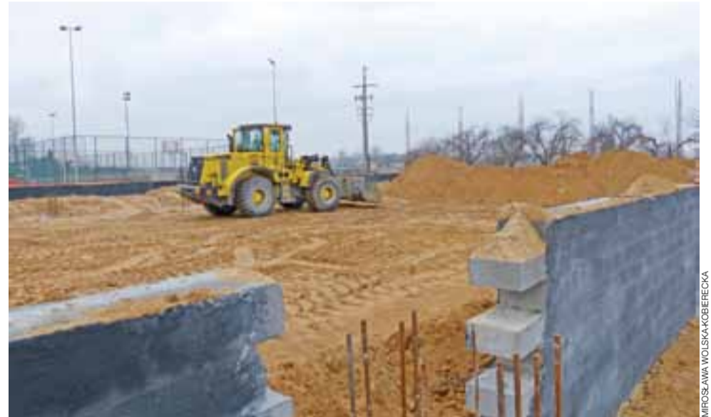
Fundamenty pod budowę sali gimnastycznej wraz z zapleczem już są zalane. Budowa będzie kontynuowana przez kolejne 2 lata.
