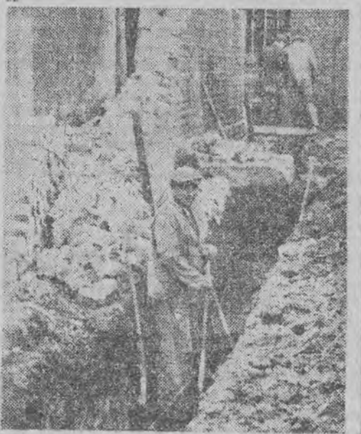
Pośpiesznie przeprowadza się kanalizację na terenie PZPB Nr 3
