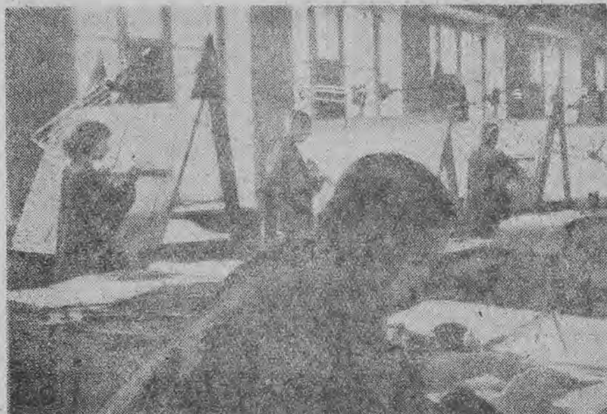
Odbudowa zniszczonych rejonów ZSRR jest podstawowym zadaniem powojennego planu pięcioletniego (1945 — 1950). Na zdjęciu inżynierowie i technicy radzieccy projektują odbudowę i budowę nowych domów mieszkalnych.
