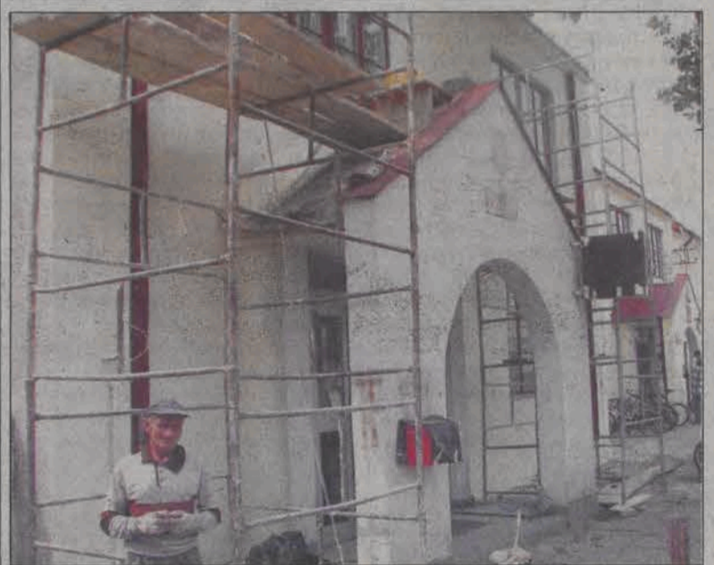
Pracownicy gminnej brygady remontowo-budowlanej tynkujący budynek Urzędu Gminy w Bolimowie przeszli już na część wynajmowaną przez gminę na siedzibę poczty. Oprócz elewacji pomalowane zostaną na kolor wiśniowy okna. Kolejnym etapem prac będzie malowanie dachu budynku.
