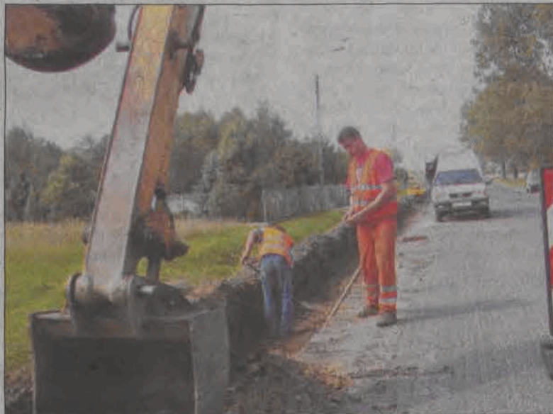
Pracownicy firmy Erbedim poszerzają podbudowę drogi.
