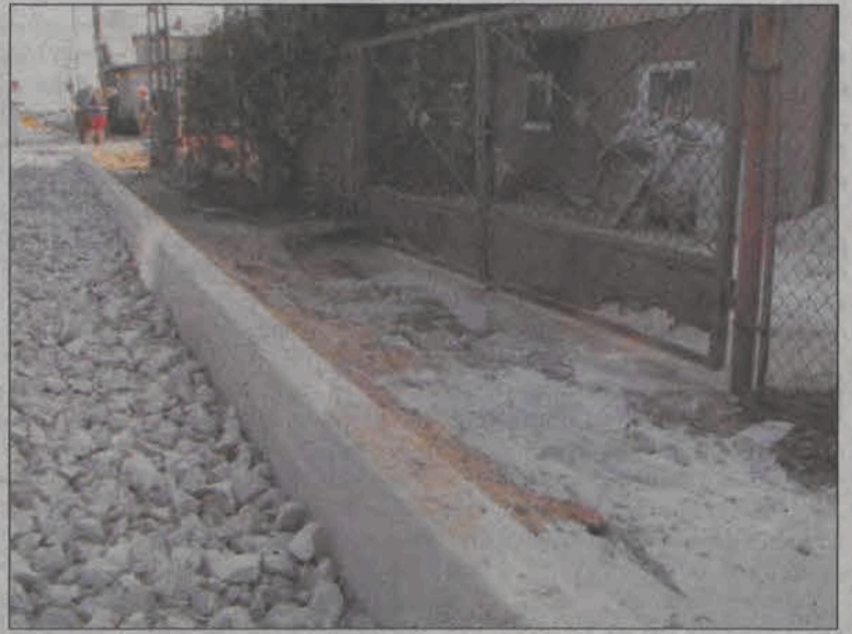
Tak wygląda różnica poziomów budowanej ul. Sobockiej i posesji przy ul. 17 Stycznia.
