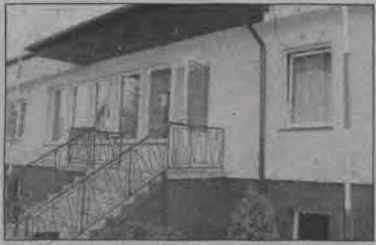
Budynek urzędu po remoncie
