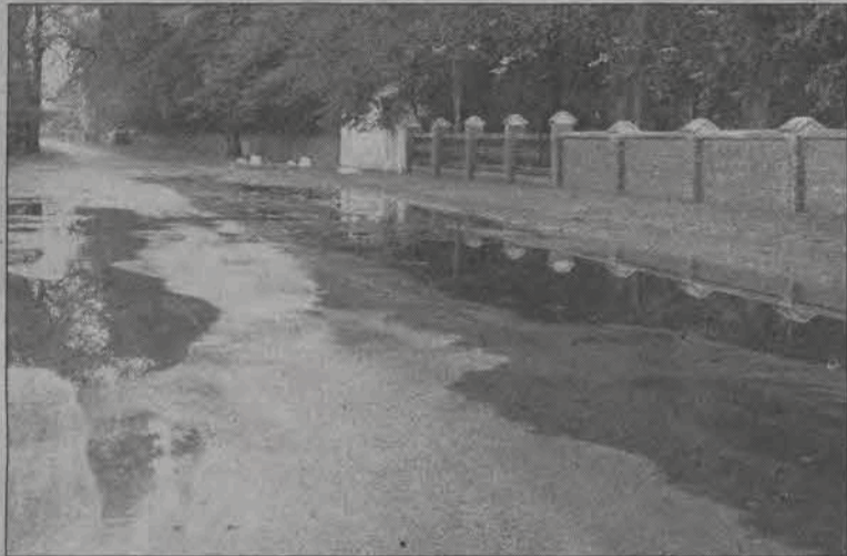
Dziury w drodze przy parku w Kiernozia po deszczu wypełniły się wodą. Mimo to widać, jak kiepski jest stan nawierzchni.
