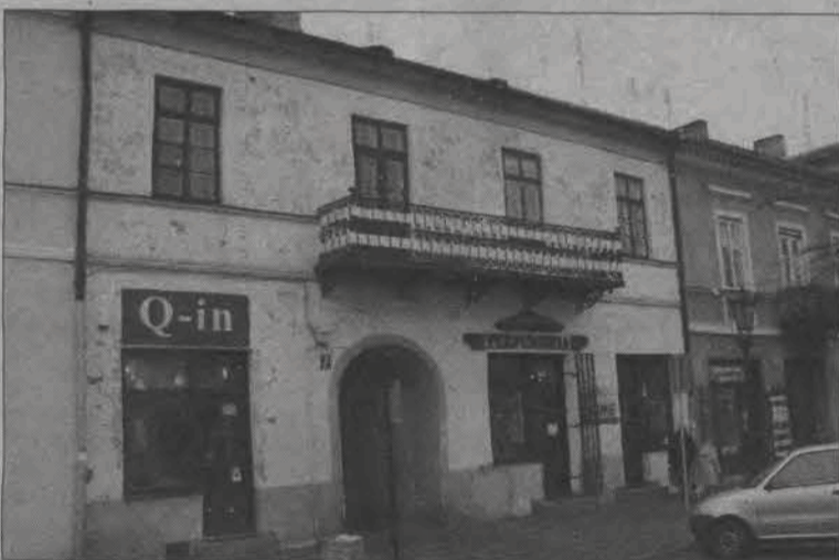
Nawet patrząc z zewnątrz, widać, że jest to jedna z najbardziej zaniedbanych kamienic przy Nowym Rynku.
