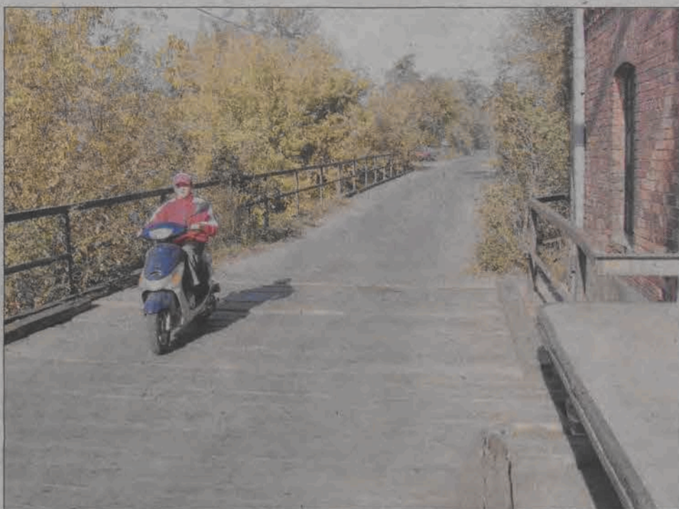
Drewniany most w Strugienicach. Z prawej widać ściany prywatnego młyna, w przyszłości ma w nim powstać elektrownia wodna.
