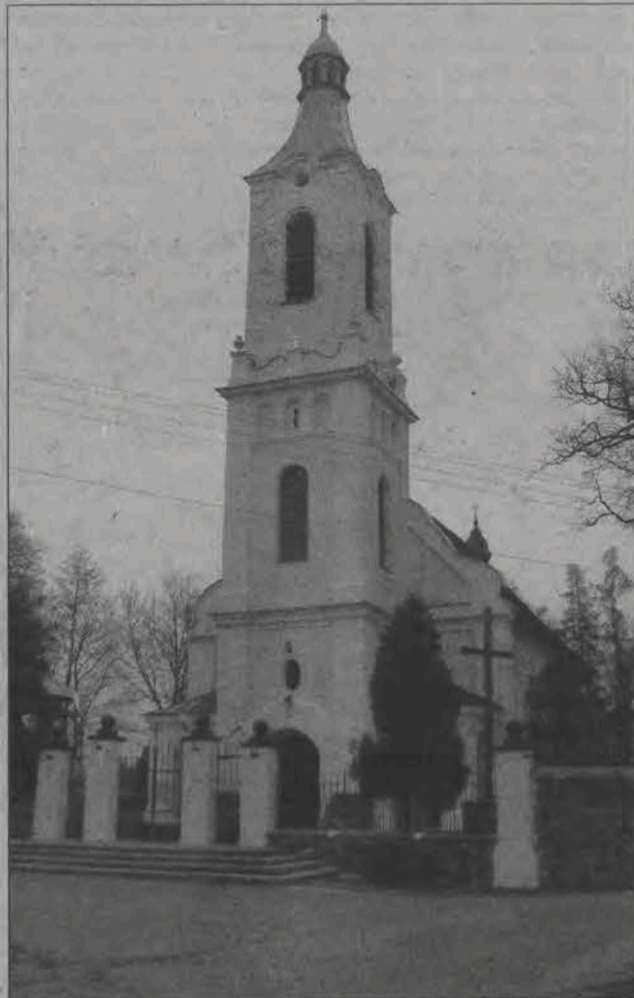
Wieża bednarskiego kościoła błyszczy już z daleka nowym miedzianym dachem.
