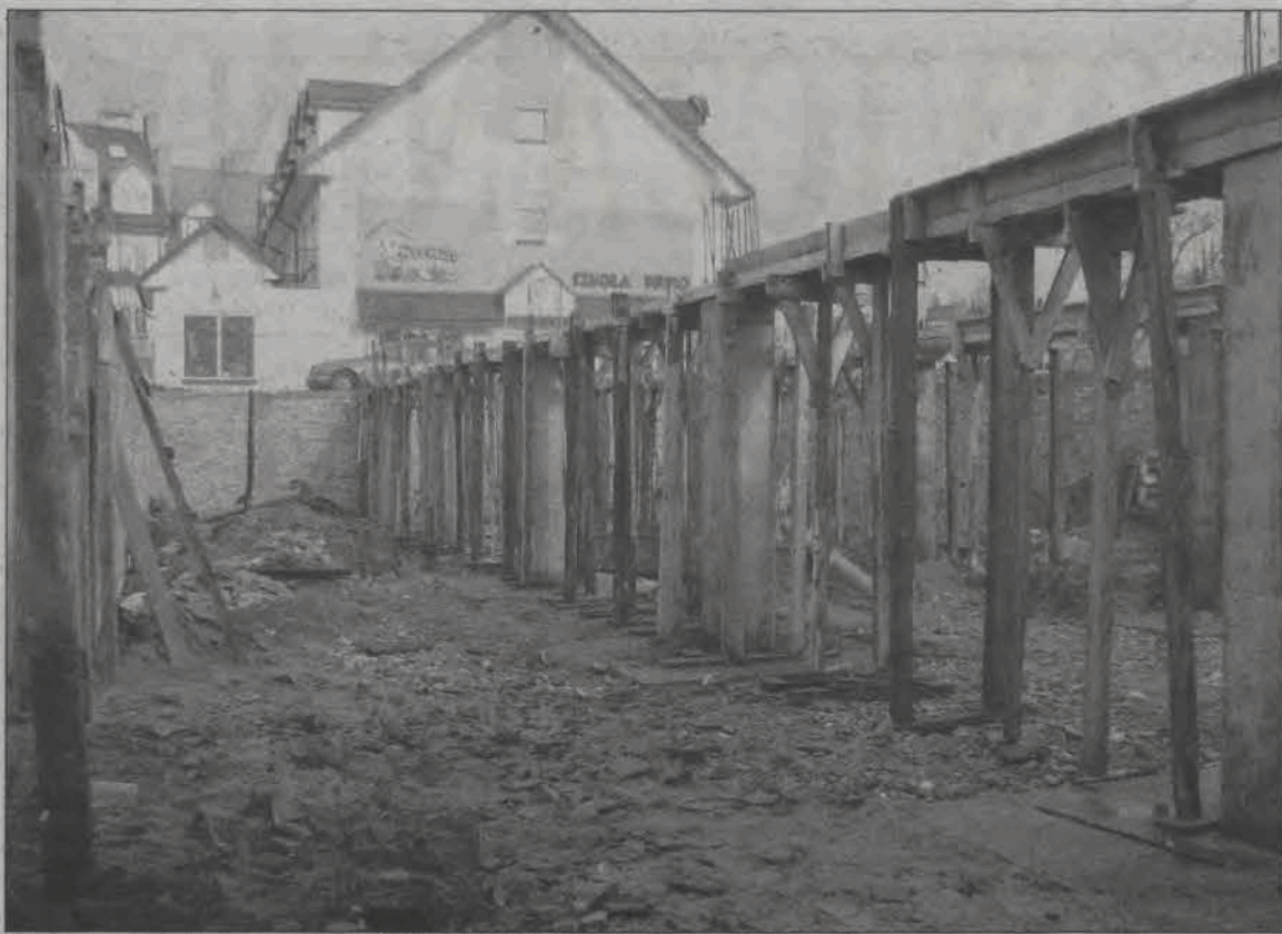
Obecnie prace trwają na poziomie piwnicy. Wkrótce zalany zostanie strop.
