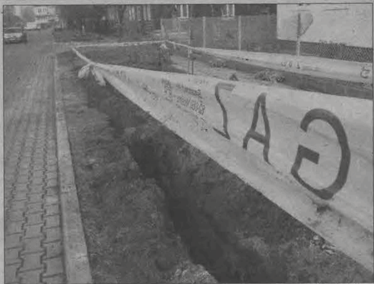
Prace przy układanej sieci gazowniczej widać m.in. na ulicy Łyszkowickiej.
